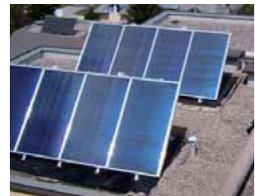
Flachdachmontage mit Rasenkantensteinen
