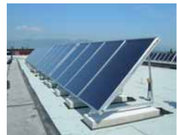
Freie Aufstellung mit Betonsteinen
